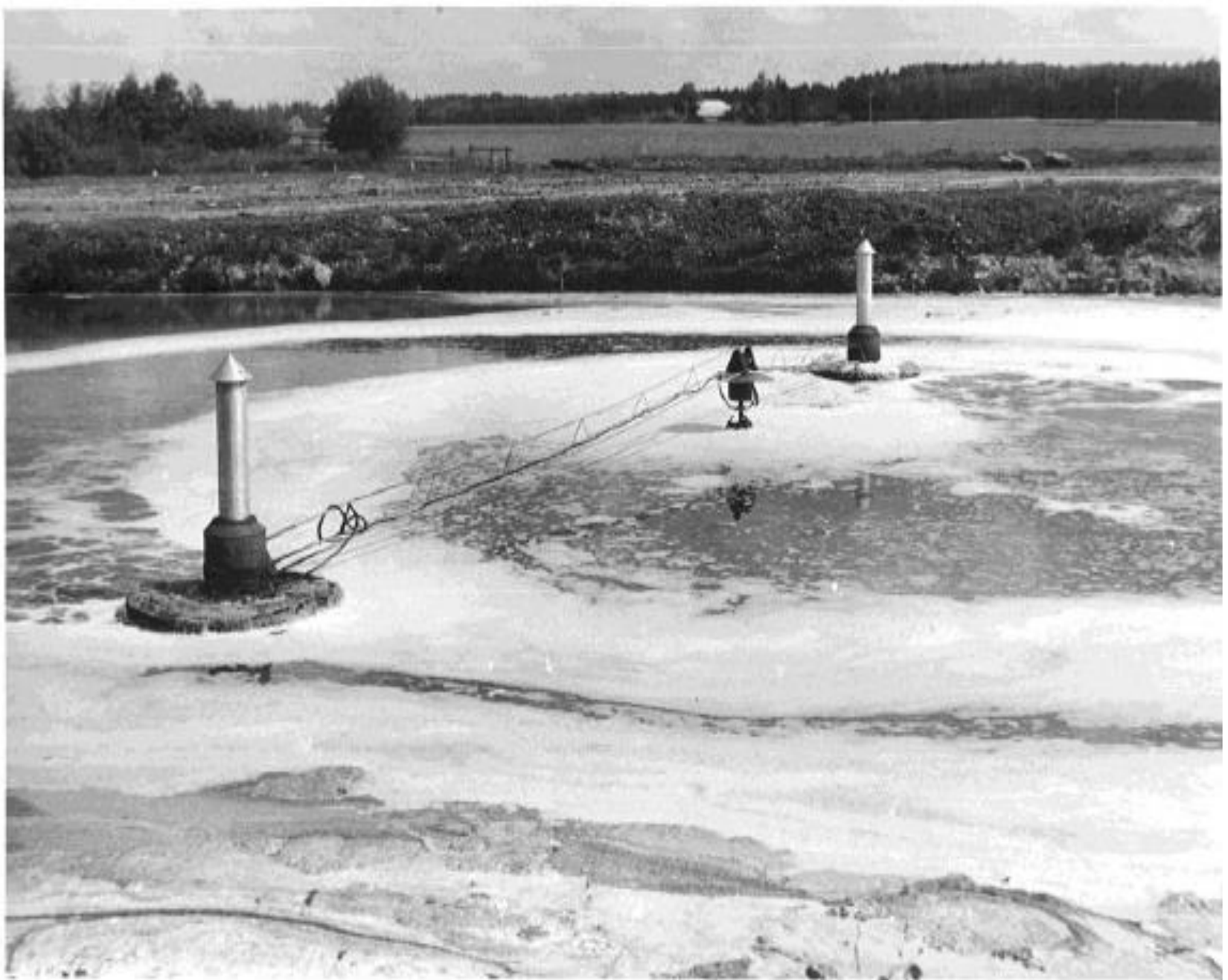
Joonis 7. Nurga tärklisvabriku liikuvate pindõhustitega biotiik. Foto A. Maastik.
