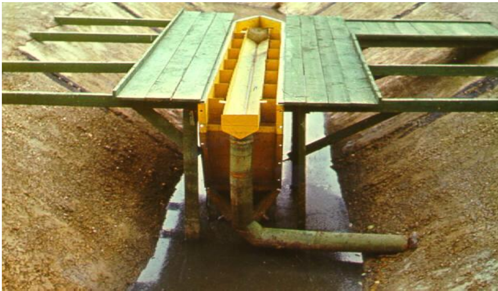
Joonis 12. Ringkanalid. Lehtersetitiga ringkanalid: a) 1 – ringkanal, 2 – setiti, 3 – trummelõhusti, 4 – aktiivmudatõstuk, 5 – teenindussild, 6 – väljavool, 7 – mudatihendi, 8 – liivapüünis, 9 – mudatihendi variant paariskanali puhul. b) Laminaarsetitiga ringkanal: 1 - juurdevool, 2 - trummelõhusti, 3 - kanal, 4 – laminaarsetiti, 5 - väljavool. c) Ringkanali laminaarsetiti. Foto M. Kriipsalu.
