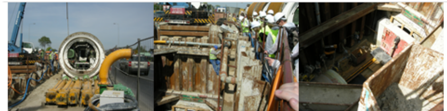
Varssavi DN3000mm tunnelkollektori ehitus 2010a
