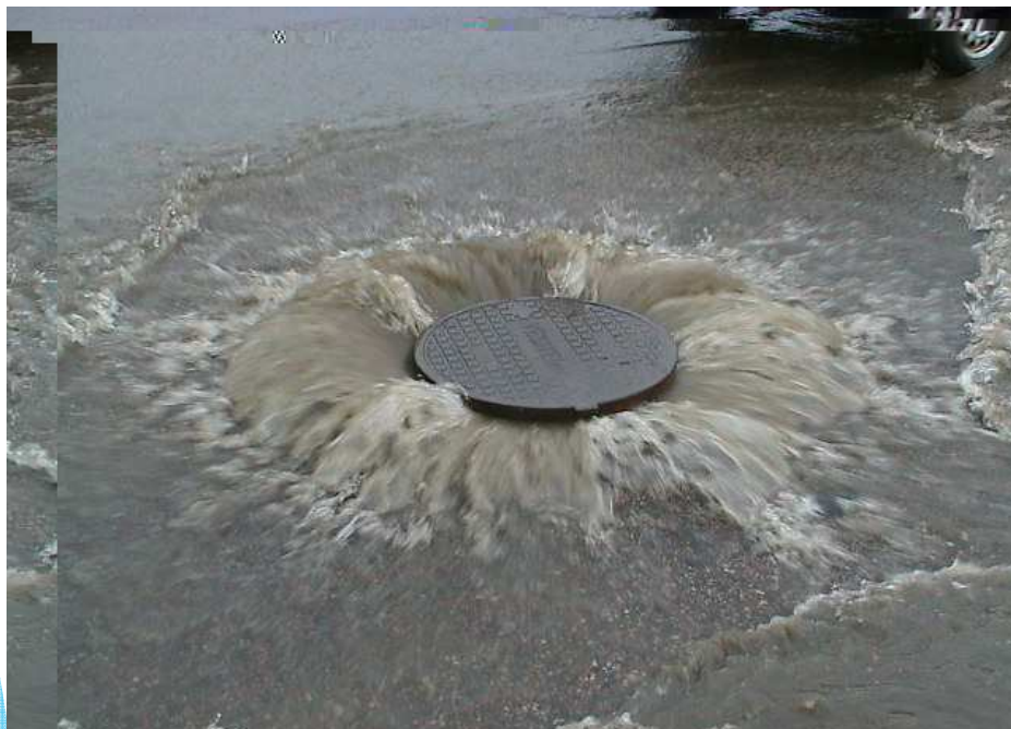
Ühisvoolse reoveekanaliseerimise kaev valingu ajal, Turu tn, Tartu
